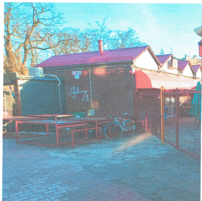
KIOSK NR W1
